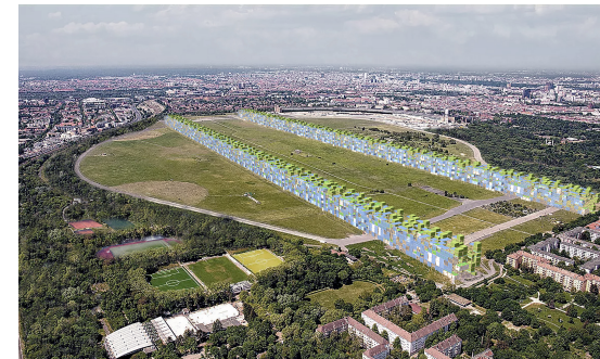
Blick nach Südwesten
